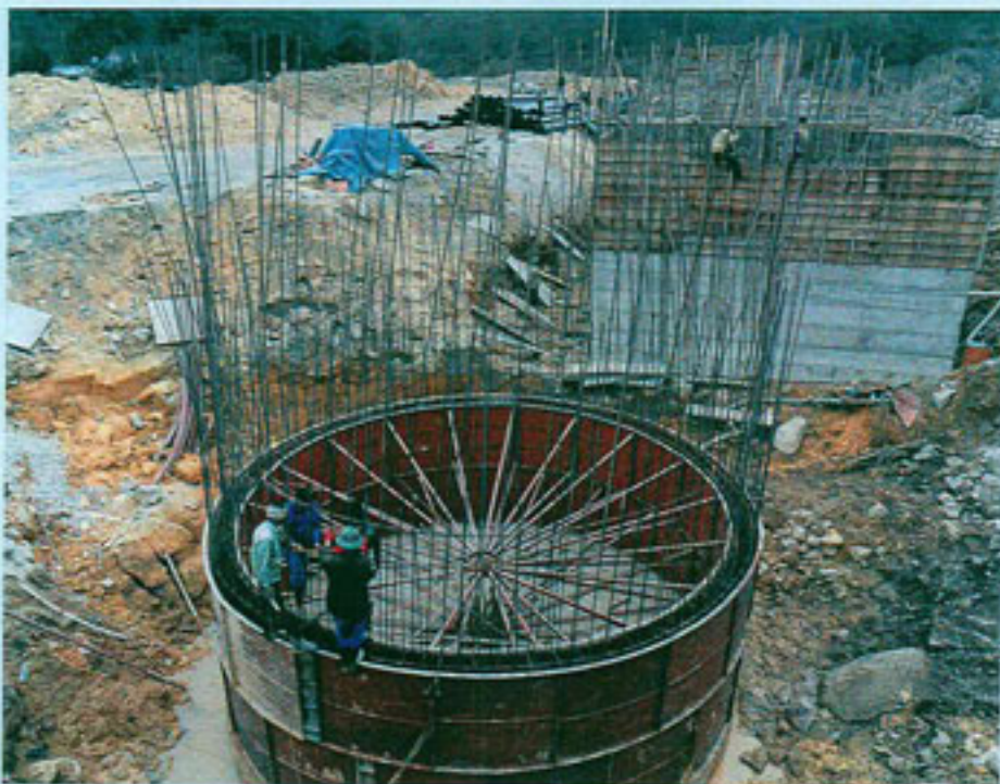
Im Januar 2011 entstanden der Schlammehindicker (Vordergrund) und das Sedimentationsbecken der ersten Ausbaustufe (Hintergrund). Bild 7
