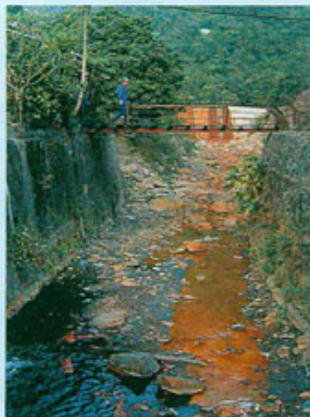
Einleitung von ungereinigtem Grubenwasser in einen Vorfluter Bild 2
