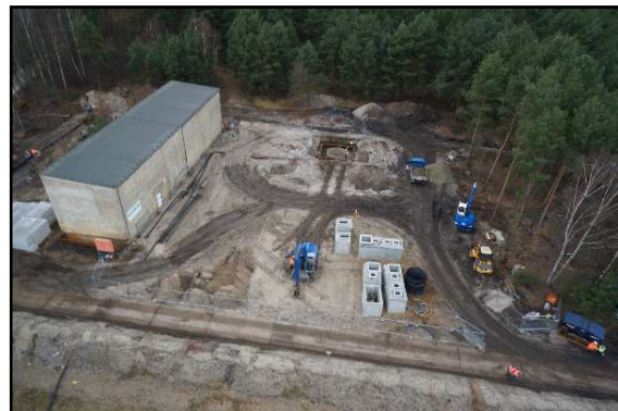
Beginn WBA Errichtung
