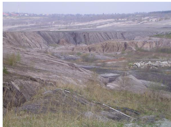
Bild 2 TB Wulfersdorf vor der Sanierung
