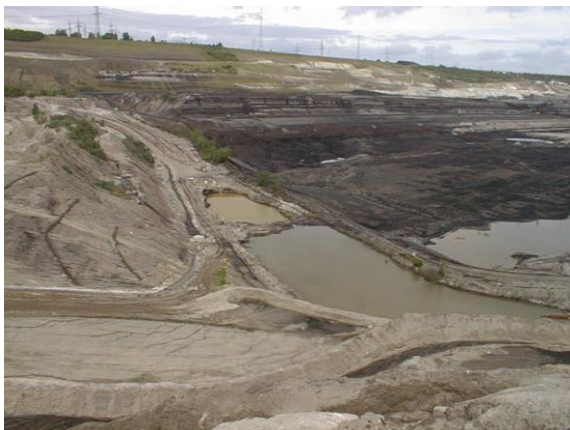
Bild 1 TB Wulfersdorf/ Helmstedt
