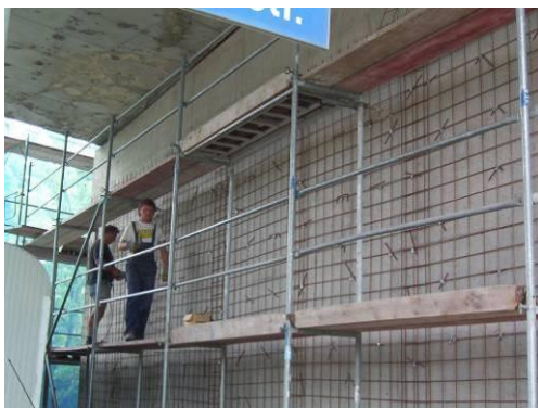
Bild 3 Spritzbeton Widerlagerwände nach ZTV - SIB
