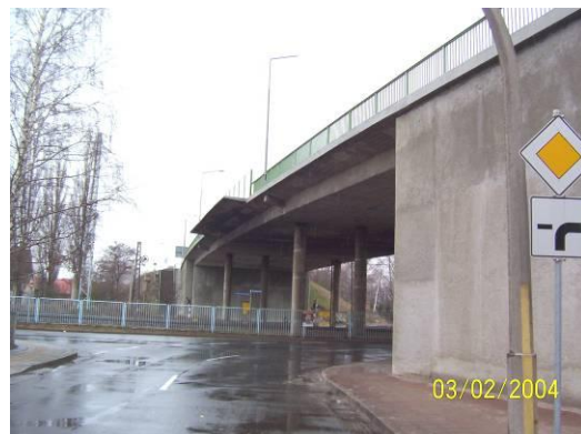
Bild 4 Spritzbeton Widerlagerwände nach ZTV - SIB
