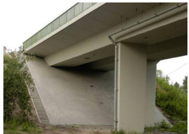
Bild 3: Bauwerk nach Instandsetzung
