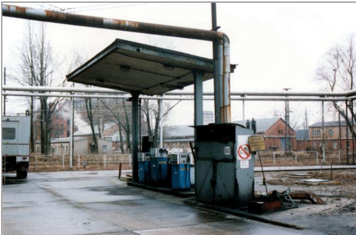
Bild 2: Dieseltankstelle vor der Sanierung
