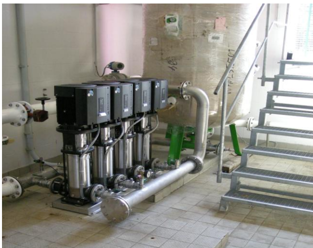
Bild 2 Druckerhöhung mit Druckkessel
