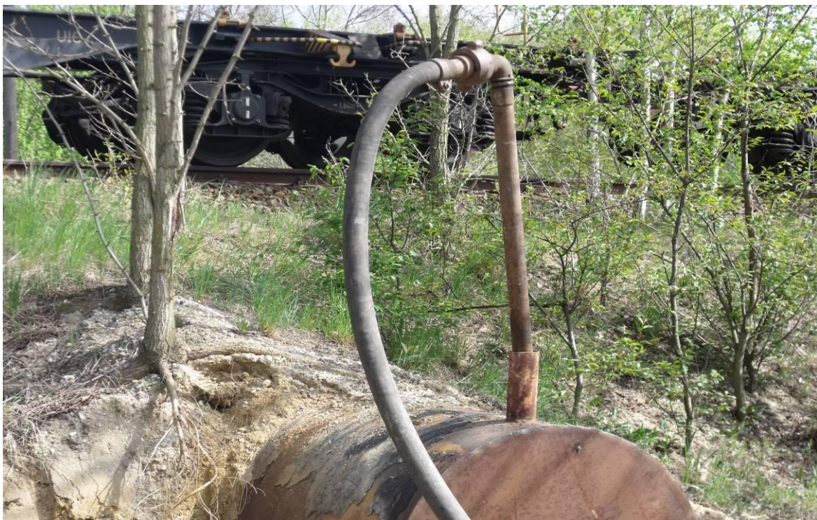
Bild 1: Verfüllung Düker
