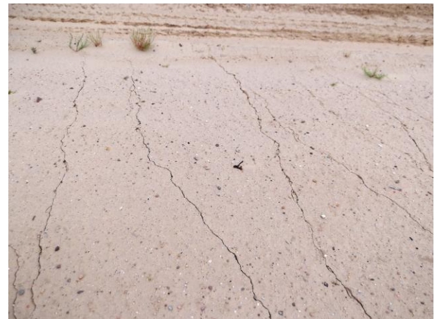
Bild 2 Begutachtung von Setzungsrisen
