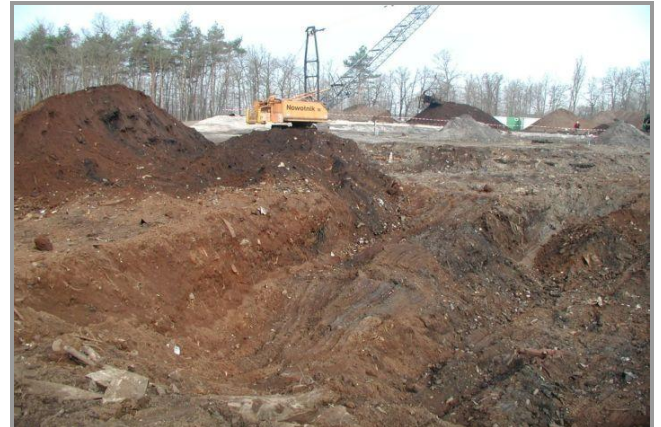
Bild 2: Auskofferrung der Deponie
