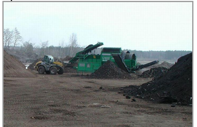
Bild 6: Beschickung der Siebanlage auf dem Zwischenlager
