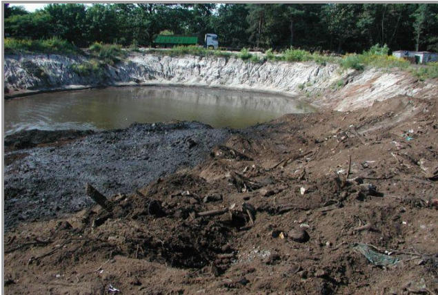
Bild 1: Müllablagerungen am Restloch 28 mit Sanierungsbeginn
