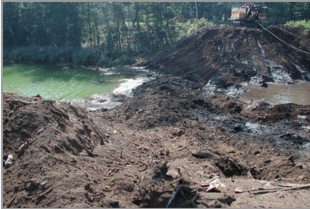
Bild 3 und 4: Auskoffnung der Deponie mit Sicherheitsdamm
