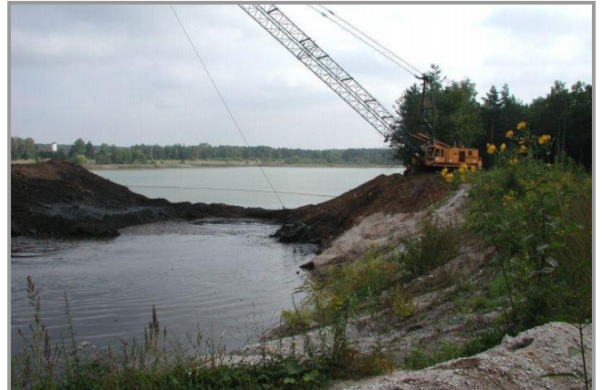
Bild 3 und 4: Auskoffnung der Deponie mit Sicherheitsdamm
