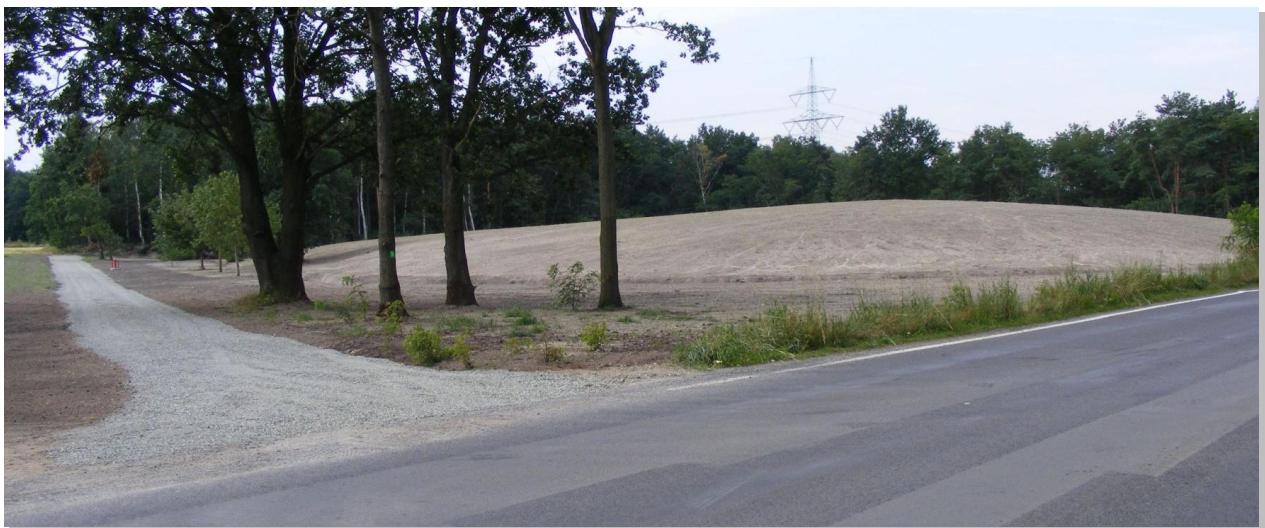
Bild 1: Ansicht Nordost der „Altablagerung Friedrichstraße“ in Hosena nach der Sanierung
