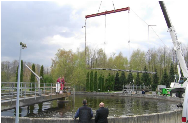
Bild 2: Austausch der Belüfter im Belebungsbecken
