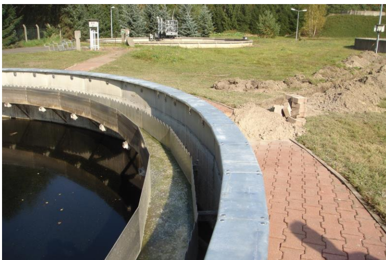
Bild 3: Räumefahrbahn fertig montiert
