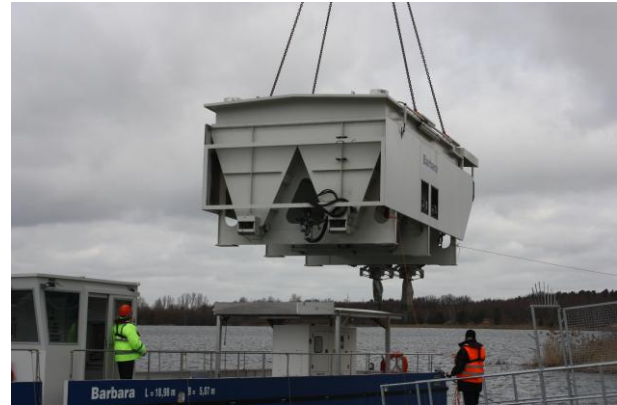
Bild 4: Einsetzen des Technikmoduls
