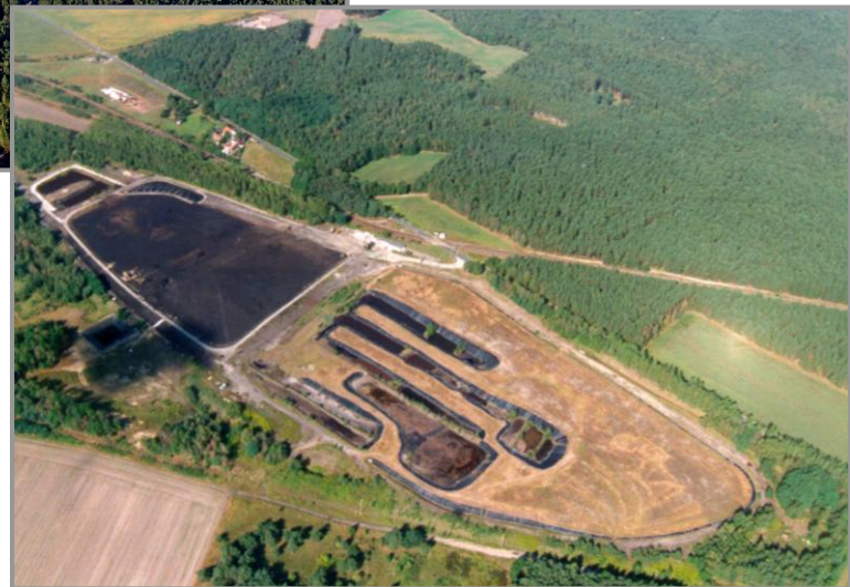
Bild 2: Abprodukthalde Deponie Terpe
