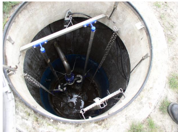
Bild 2 Blick in einen Schacht
