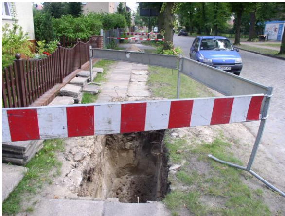
Bild 1 Schachtung für die grabenlose Verlegung
