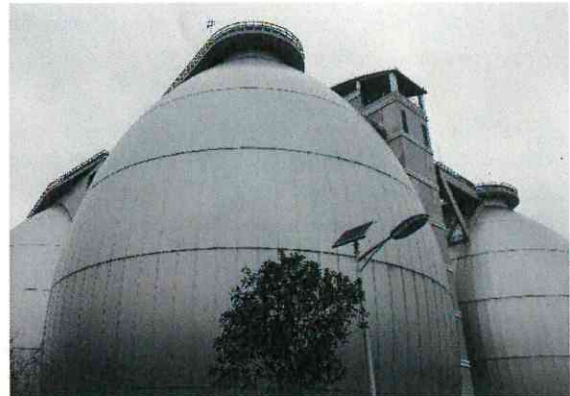
Faultürme einer chinesischen kommunalen Kläranlage
